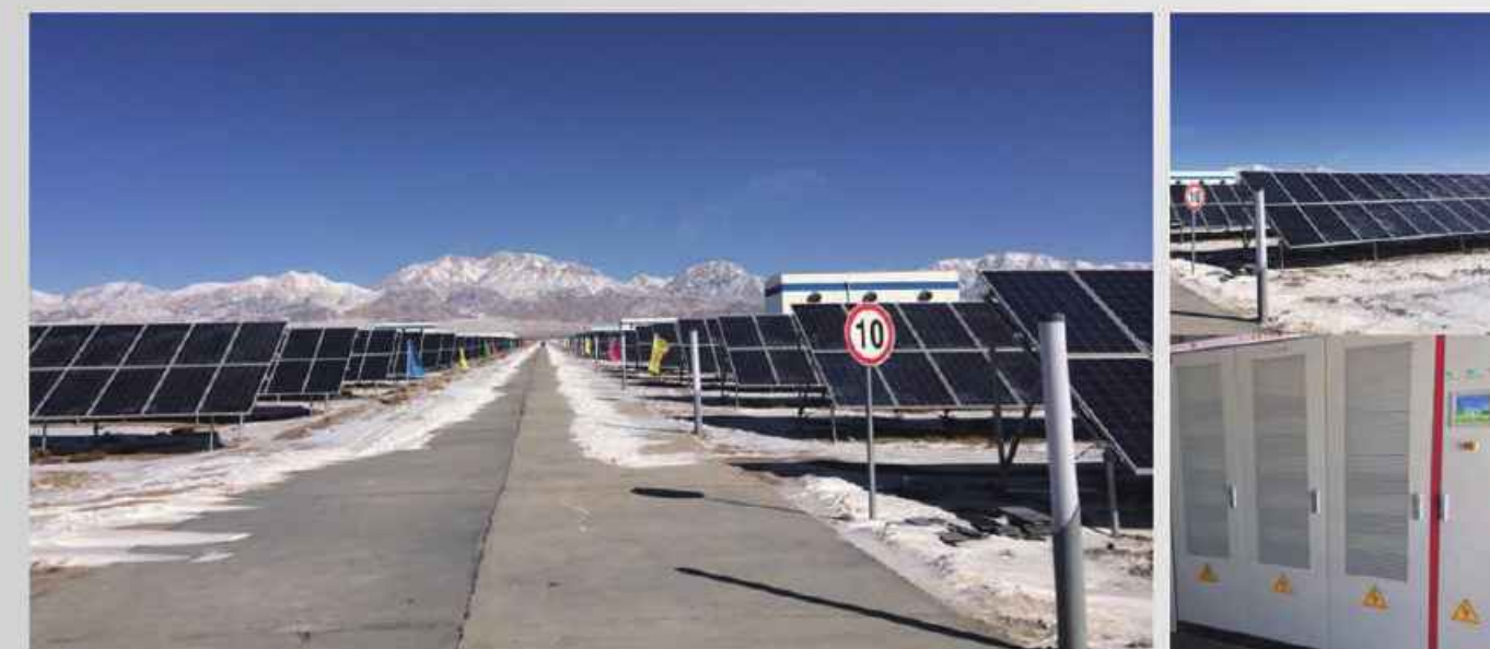
项目名称：青海德令哈 - 15.2MW 光伏电站三期工程
