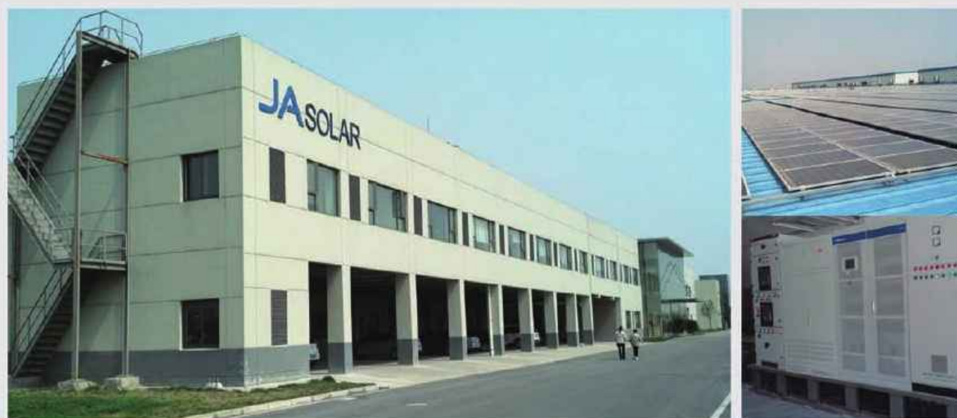
项目名称：上海晶澳太阳能奉贤工厂 - 2.85MW 光伏电站示范工程
