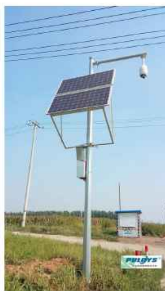
伊春移动基站太阳能供电系统
