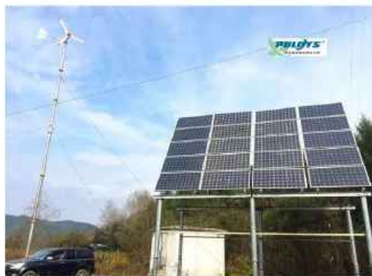
伊春移动基站太阳能供电系统
