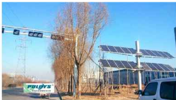
大庆交通信号灯太阳能供电系统
